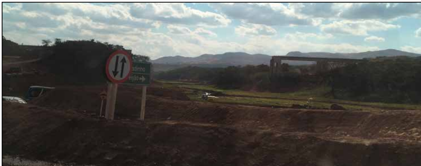
El puente ferroviario roto ilustra los daños causados por el colapso de la presa.
