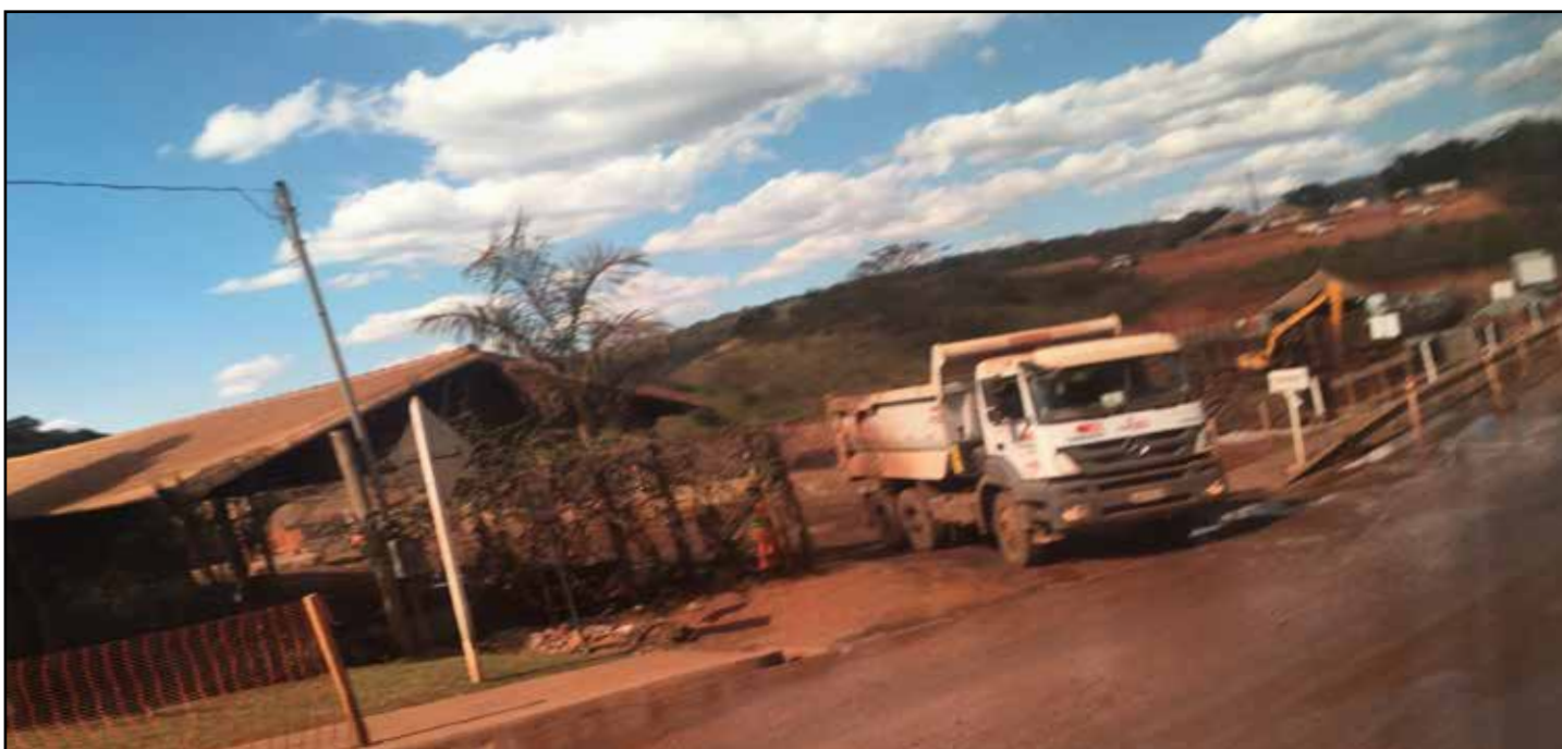
El camión que transporta el lodo lejos del sitio deja el área
